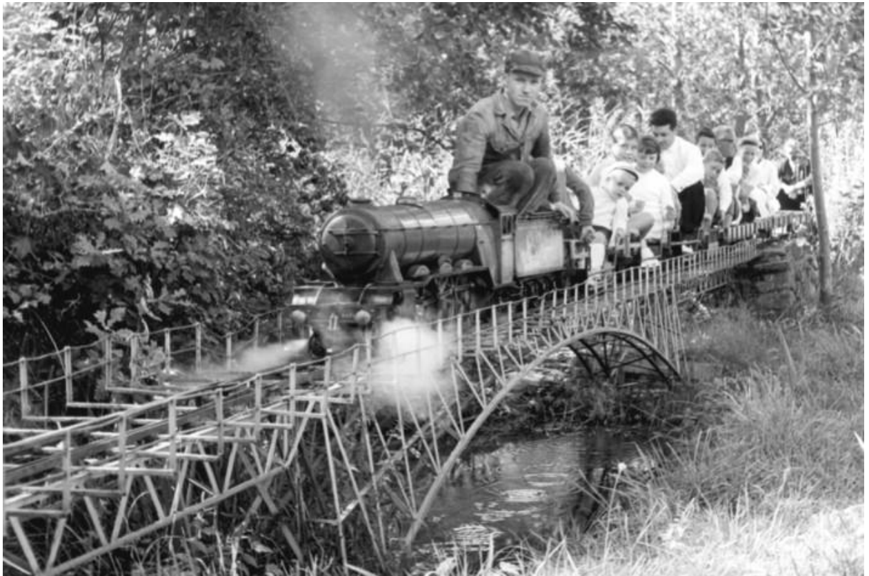
Royal Scot überquert die „Sambesi Brücke“
